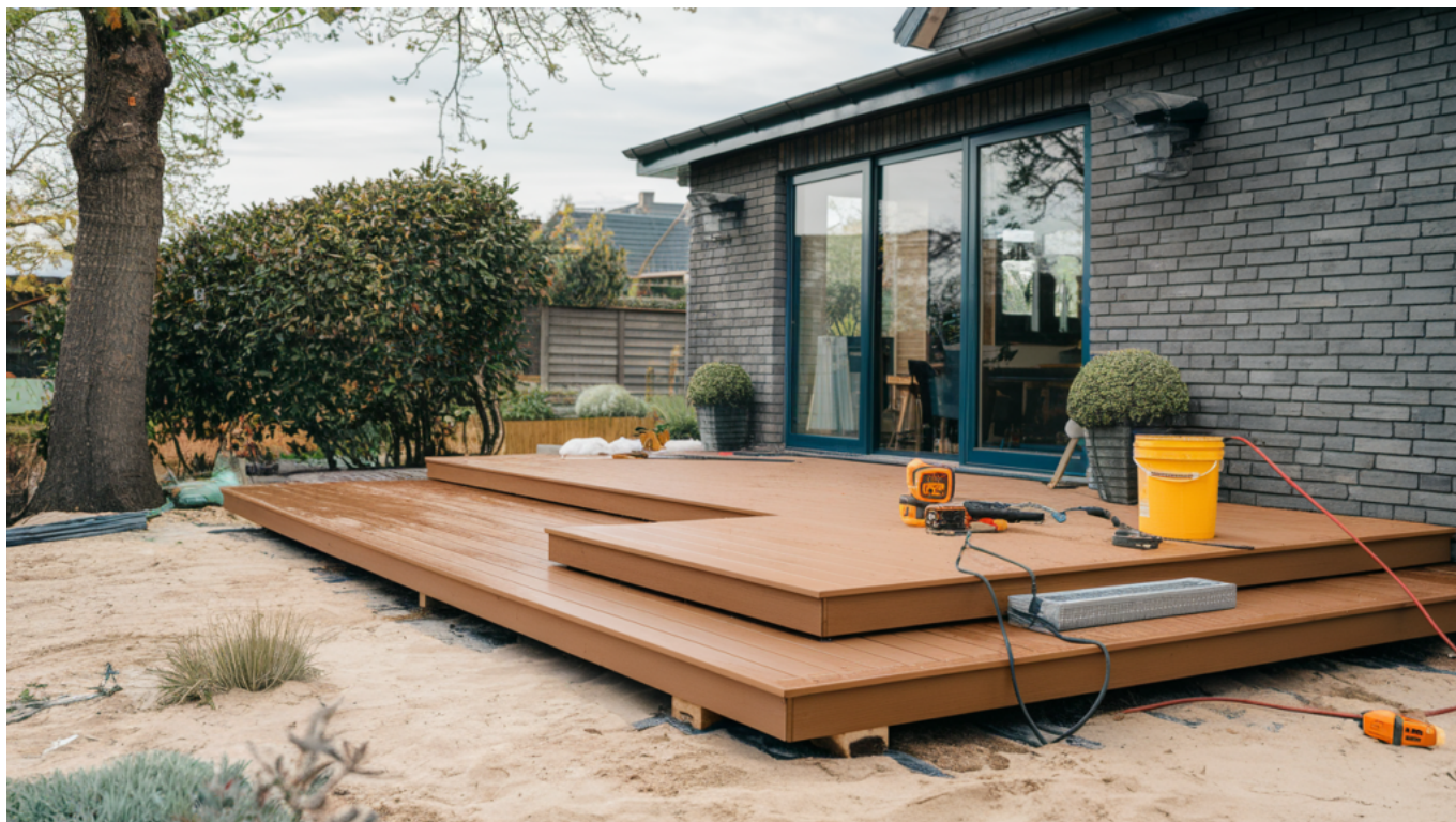
Zdjęcie poglądowe - konserwacja po montażu
