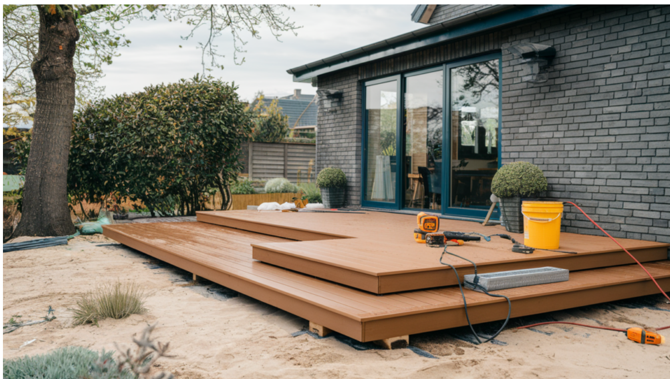
Zdjęcie poglądowe – konserwacja po montażu
