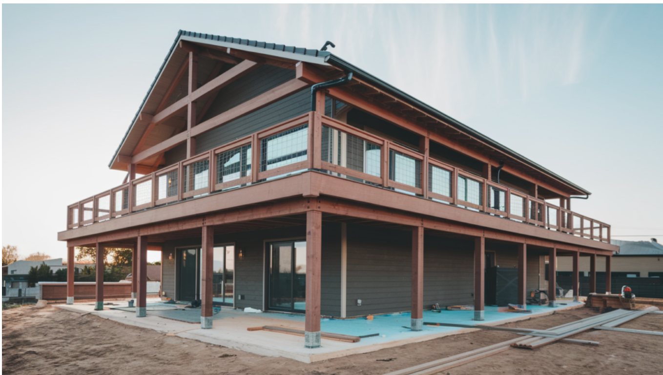
Zdjęcie poglądowe – przygotowanie podłoża pod taras z deski kompozytowej
