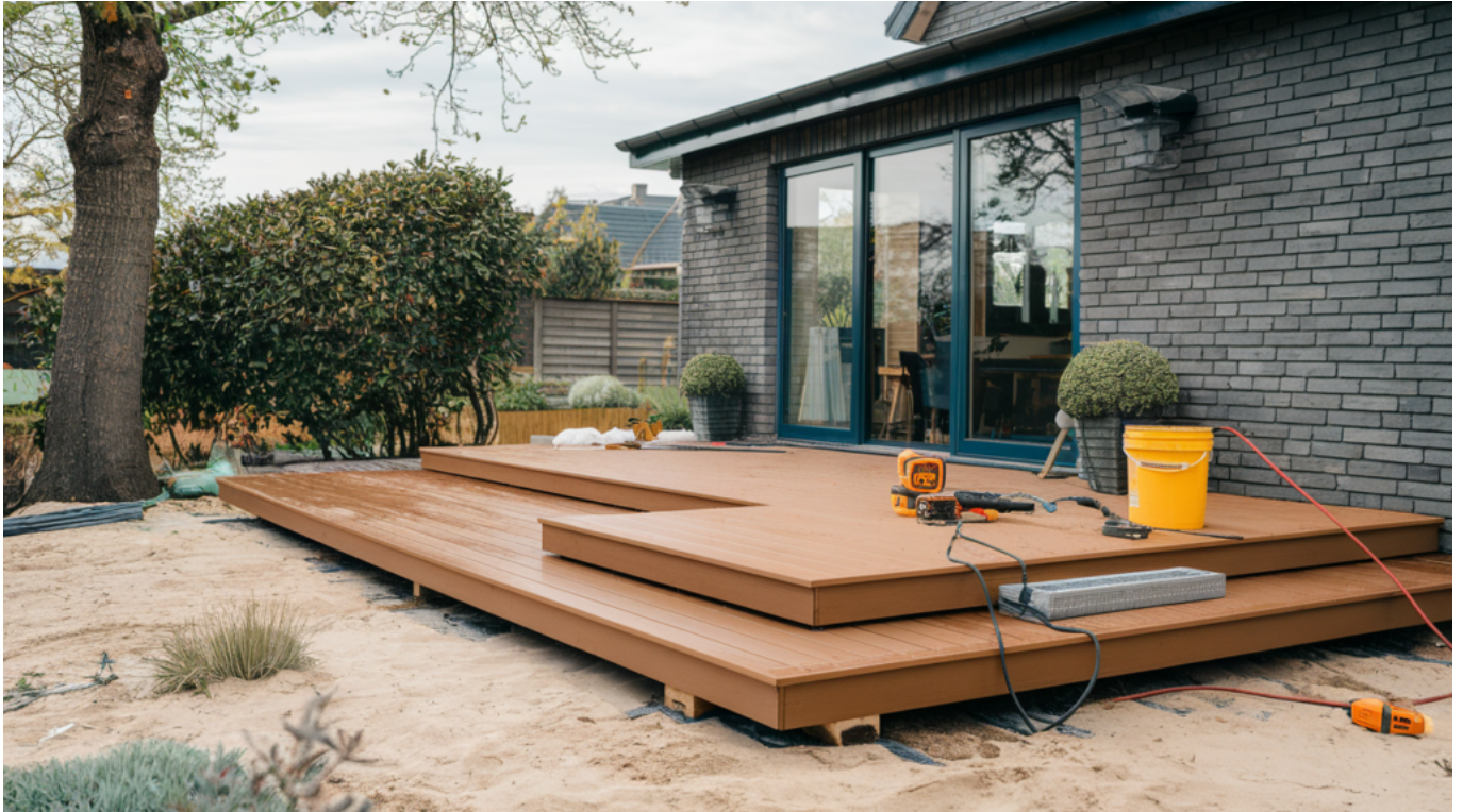
Zdjęcie poglądowe - konserwacja po montażu
