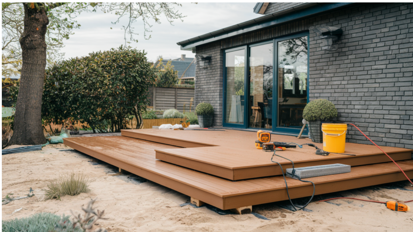
Zdjęcie poglądowe - konserwacja po montażu
