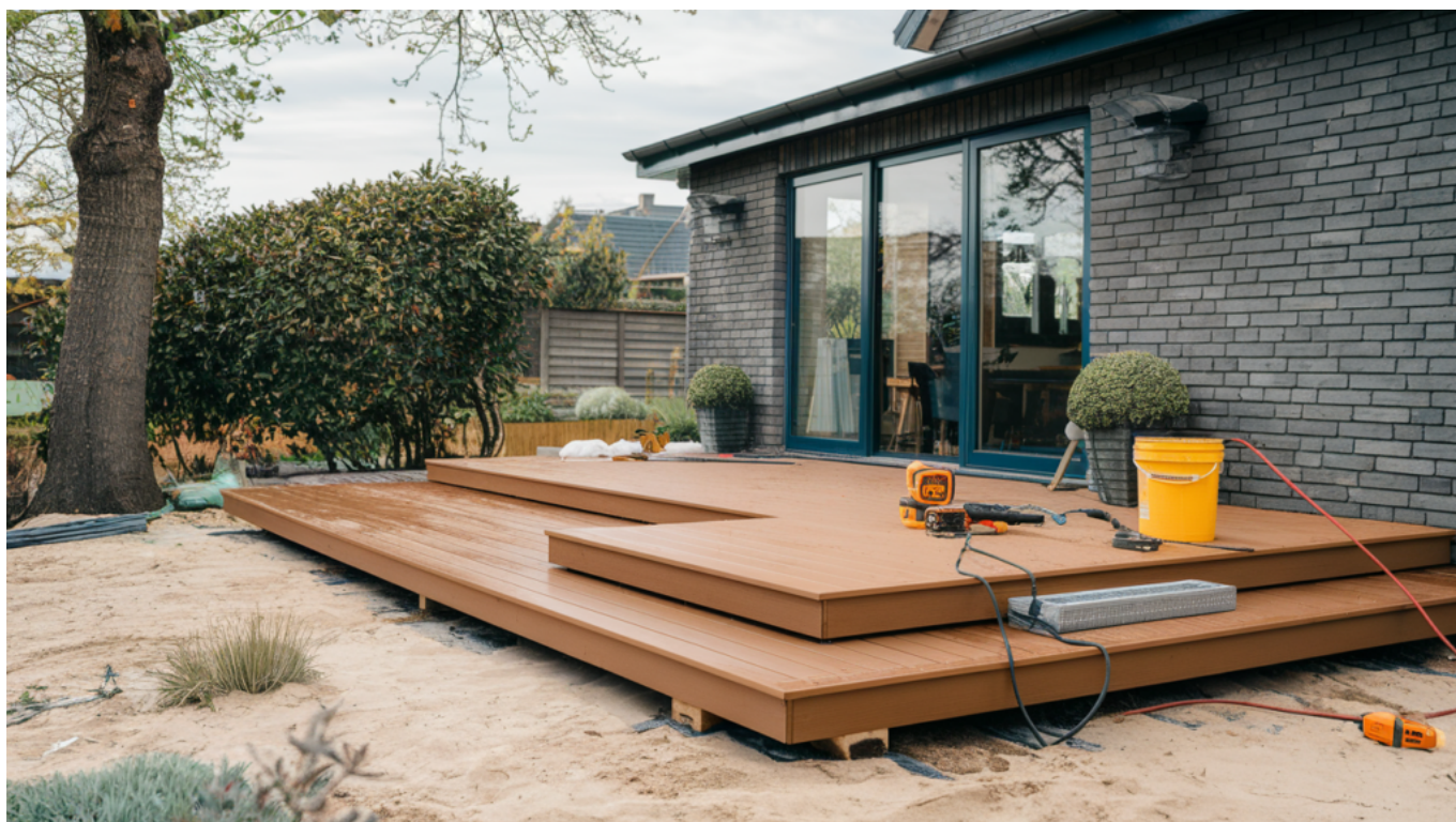
Zdjęcie poglądowe – konserwacja po montażu
