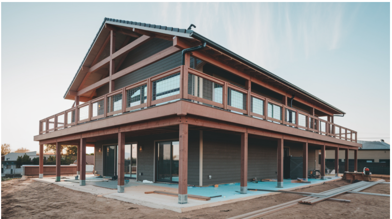
Zdjęcie poglądowe – przygotowanie podłoża pod taras z deski kompozytowej
