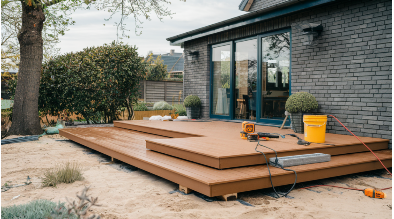
Zdjęcie poglądowe - konserwacja po montażu
