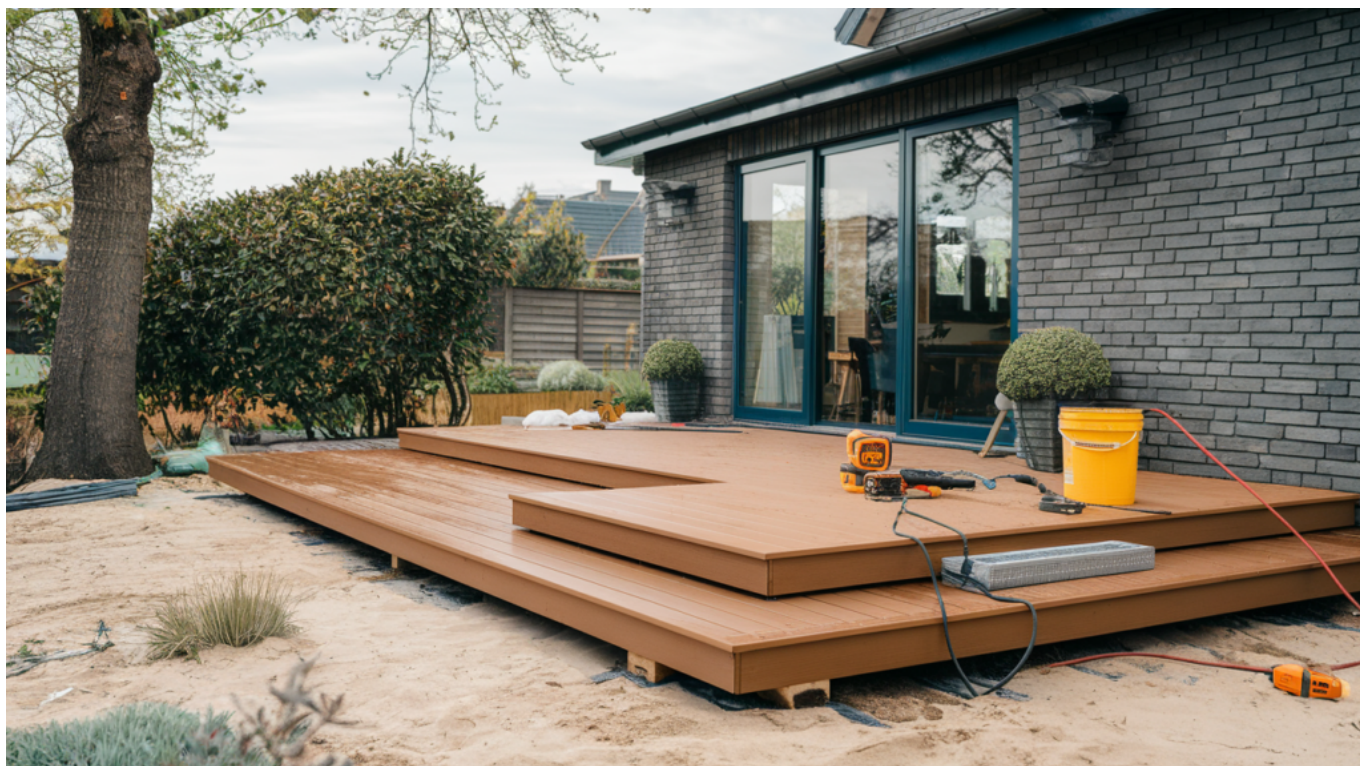
Zdjęcie poglądowe – konserwacja po montażu
